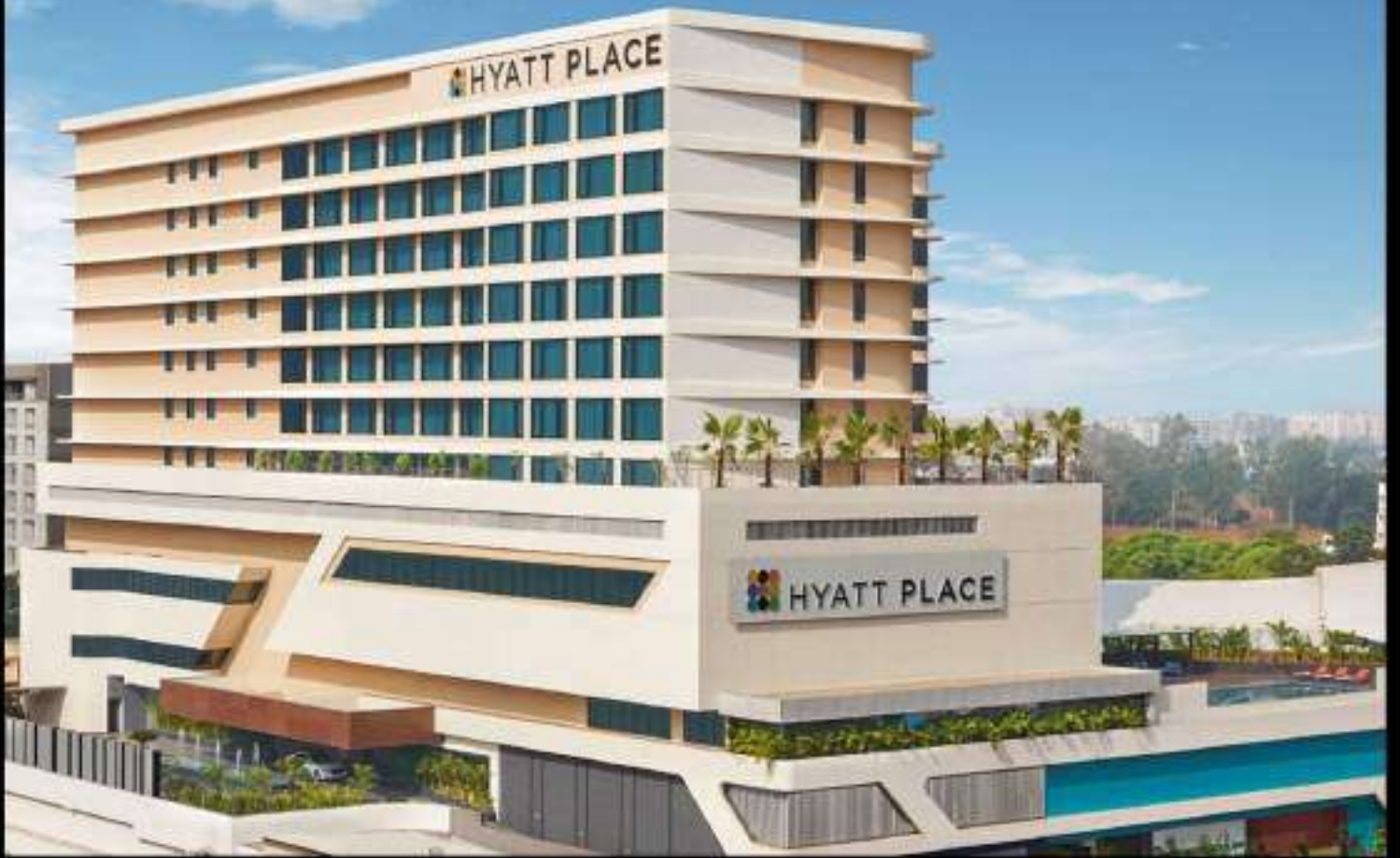
Project : Hotel HYATT PLACE (Vadodara)
