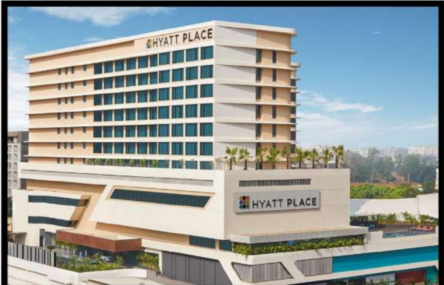
Project : Hotel HYATT PLACE (Vadodara)
